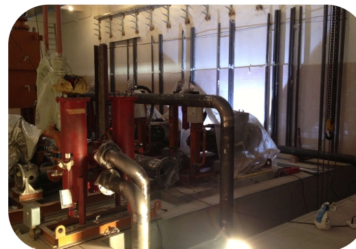
Травление, промывка и опрессовка трубопроводов систем смазки
