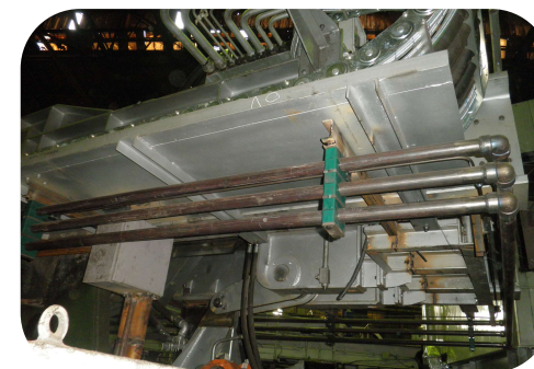
Монтаж, промывка трубопроводов
