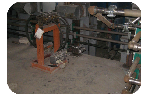
Монтаж и промывка трубопроводов
