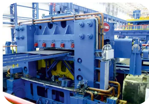
Капитальный ремонт листовых ножниц
