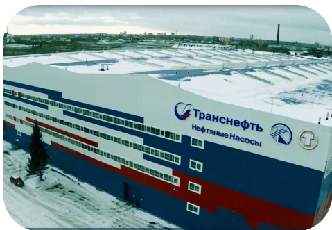
Испытательный центр АО «ТНН»
