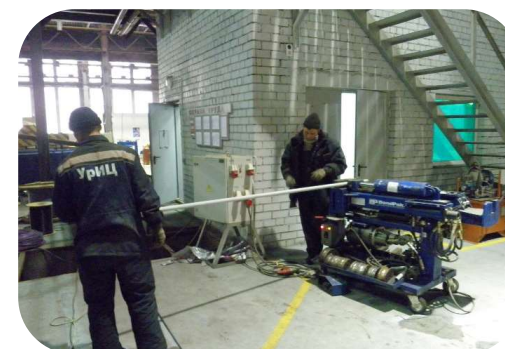
Трубная разводка и монтаж
